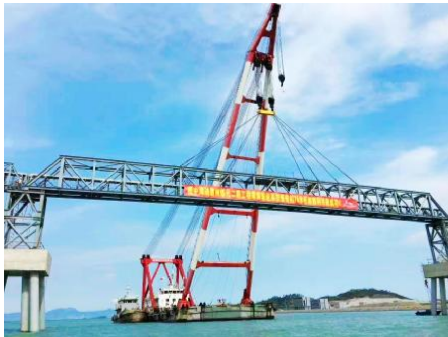
跨海输煤栈桥管带机76米桁架吊装成功
