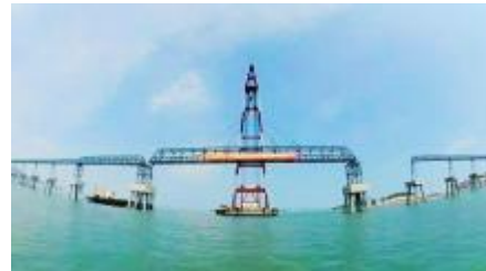
千米跨海输煤栈桥雄姿
