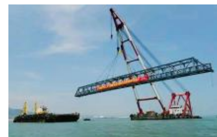
项目部使用大型海吊船开展吊装作业
