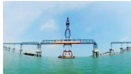
千米跨海输煤栈桥雄姿
