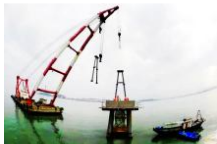
跨海输煤栈桥海上首吊圆满完成
