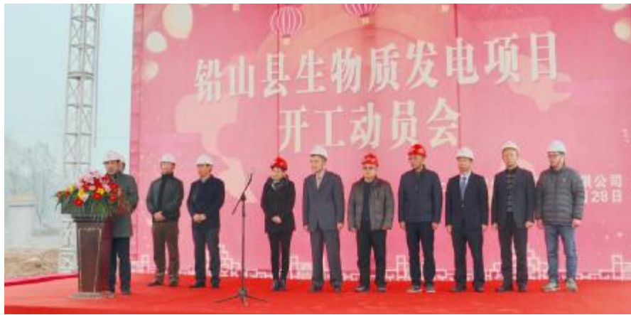
铅山县生物质发电项目是公司近年来在生物质发电施工总承包领域承接的大项目,工程位于江西省上饶市铅山县,合同价款1.5亿元。六分公司经理、党委书记舒伯乐,副经理、工会主席郑世土等参加开工典礼。 办公室
