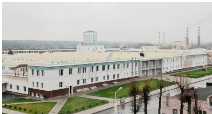
白俄罗斯奥尔沙亚麻厂技术改造项目2号厂房全貌
